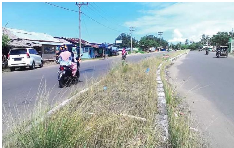
Gambar 7: Kondisi jalan lingkar Kota Lhokseumawe yang perlu penghijauan
